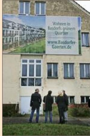
■ In Basdorf entsteht das größte Bauprojekt der Gemeinde.
