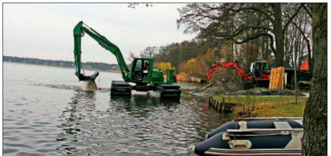
■ Der gepanzerte Schwimmbagger soll das Strandbad von Munition befreien.
