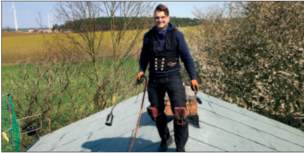
■ Fabian Seidner bietet einen breiten Service rund um Dacharbeiten. Weitere Spezialität ist das perfekte Aufstellen von Carports.
