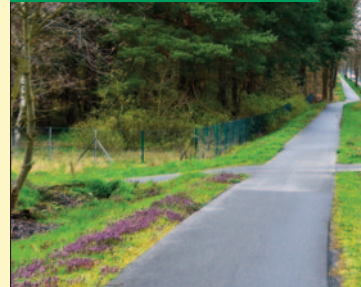
Der Radweg von Klosterfelde nach Zerpenschleuse ist jetzt sicher befahrbar.
