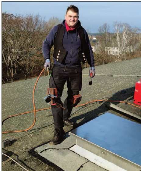
■ Fabian Seidner bietet einen breiten Service rund ums Dach.
