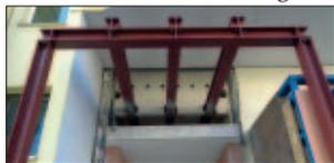
■ Vor der Erweiterung der Hauseingänge wurden in der Maxie-Wander-Straße (o.) die Außenwände abgefangen. So wurde mit dem Einbau neuer Treppenkonstruktionen der Zugang zum hofseitigen Aufzug (r.) und damit zu den Wohnungen barrierefrei.
