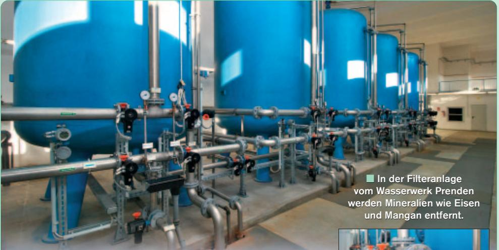
■ In der Filteranlage vom Wasserwerk Prennden werden Mineralien wie Eisen und Mangan entfernt.
